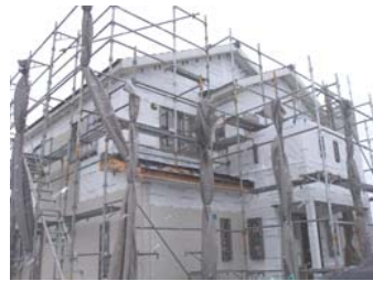
F様邸工事中
