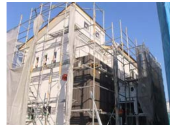
O様邸工事中
