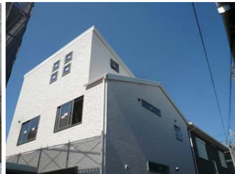
東面より撮影
