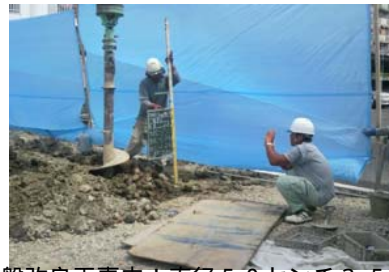
地盤改良工事中！直径50センチ3.5m地中杭25本打設！
